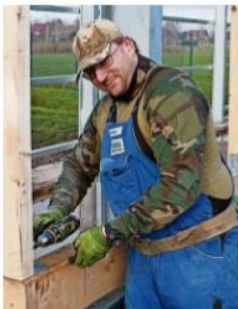
Monteur Benedikt Franz bei den vorbereitenden Arbeiten für die Installation von Rollos an der Anlaufbahn.
